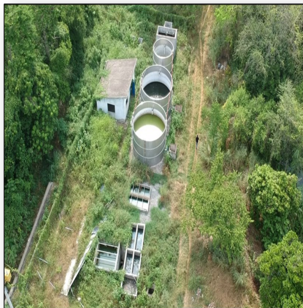
Figura 3 Planta Tratadora de Aguas Residuales fuera de operación. Comunidad de Atlaltipa, Atlapexco, Hgo. Fuente: Fotografía de la colección de los autores
